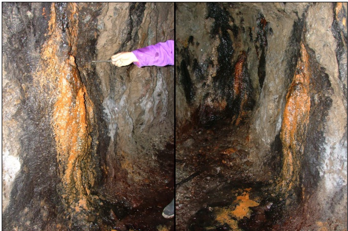
Infiltrations d'eau dans la galerie des concrétions (photos Arnaud Poujade – août 2012)
