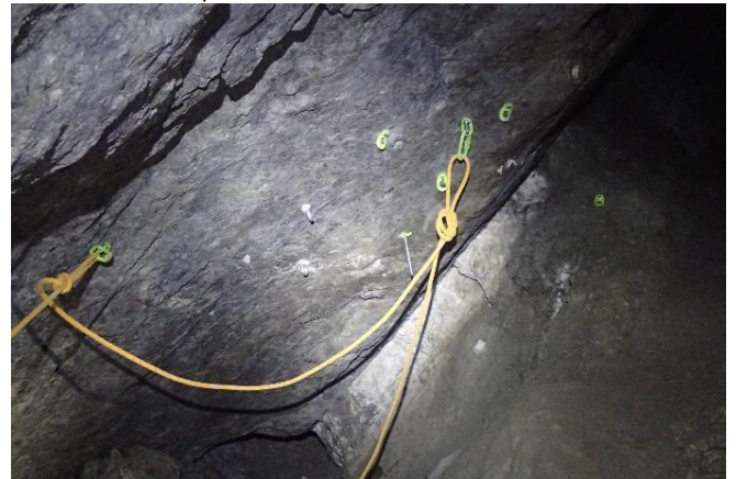
Une partie des amarrages préparés pour les tests.
