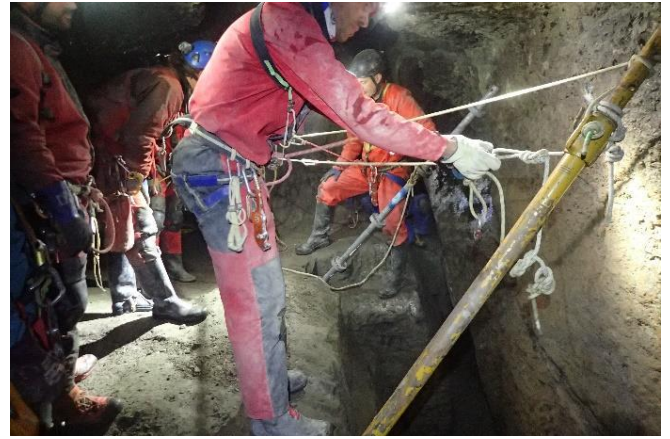
Mise en place d'un tube Multi D, et d'un étau de maçon en compression entre sol et plafond.
