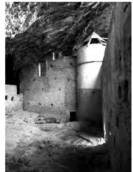
Fig. 11 : Dans l'aile ouest, un mur barre la grotte sur la gauche. Les trous de boulins sur le mur du corps central devaient supporter un balcon et des escaliers. À droite, à partir de la porte d'accès, des escaliers sont creusés dans le roc.
