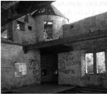
Fig. 8 : Le premier étage du corps central et ce qu'il reste de planchers. On voit la belle fenêtre géminée et l'accès aux tours.
