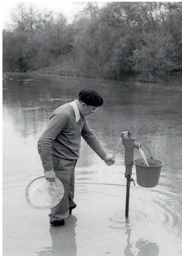
Les premiers essais d'échantillonnage de la faune interstitielle dans les sédiments du Rhône à l'aide d'une pompe à main fixée sur une sonde mobile (méthode du pompage Bou-Rouch, années 1970).
